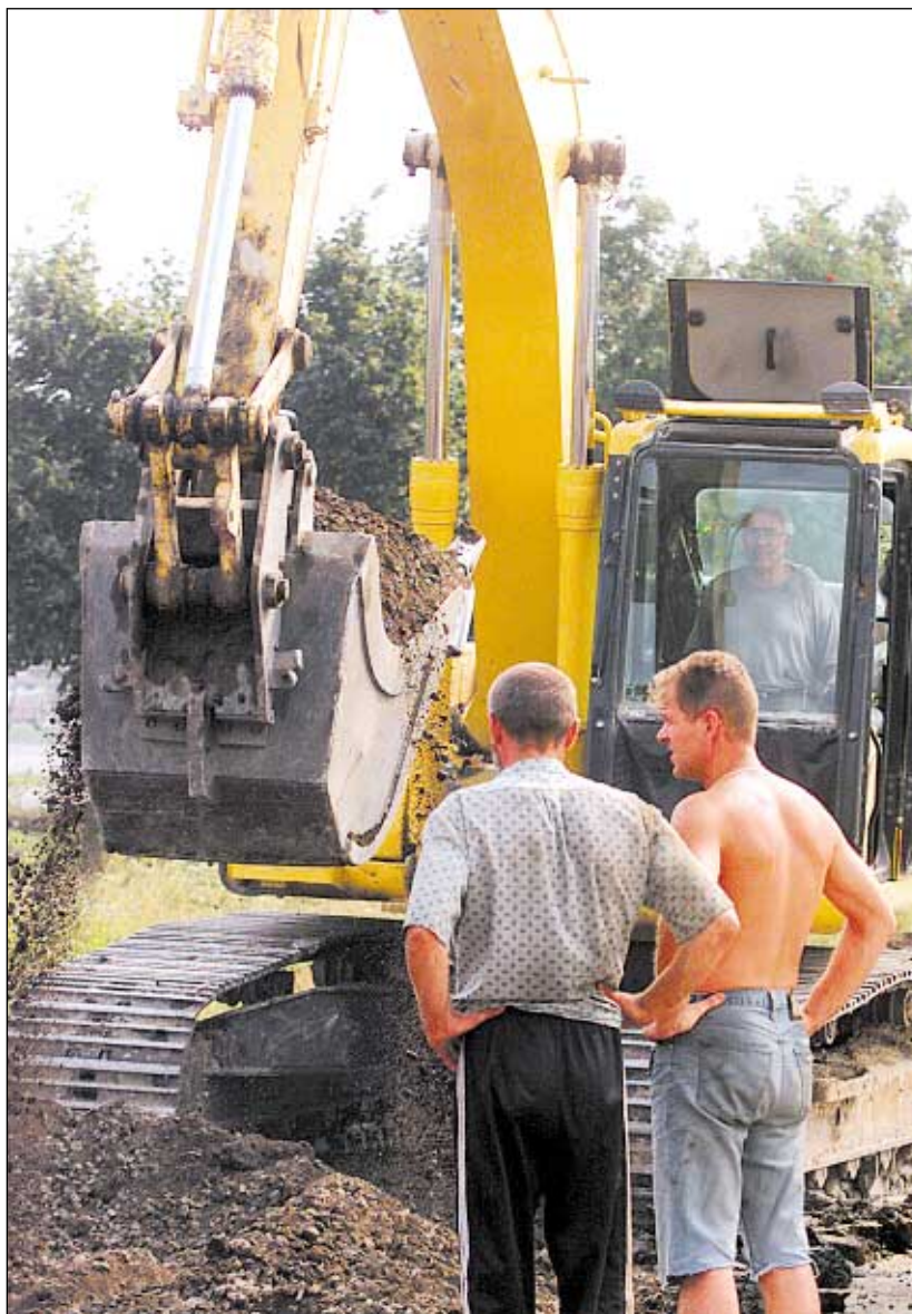
Möödunud nädalal algas tulevase spordihalli asukohas vundamendi- augu kaevamine ja pinnase äravedu.
