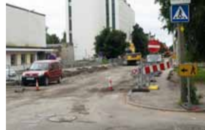
Ремонтные работы на улице Палласти
