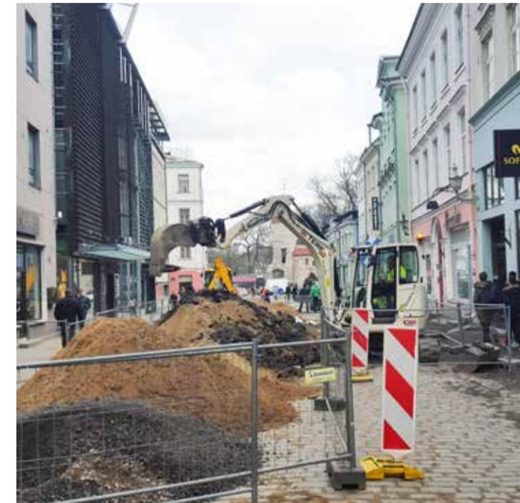
ülesvõtmise ning vee- ja kanalisatsioonitrasside, samuti tänavavalgustuse paigaldus. Sillutustööde alustamisega Vanal turul liigutakse vana teekatte lammutamise ja teekonstruktsiooni aluskihtide ehitusega Viru tänavala 70 m pikkusele lõigule. Seal on planeeritud sillutustööd alustada juunis.
