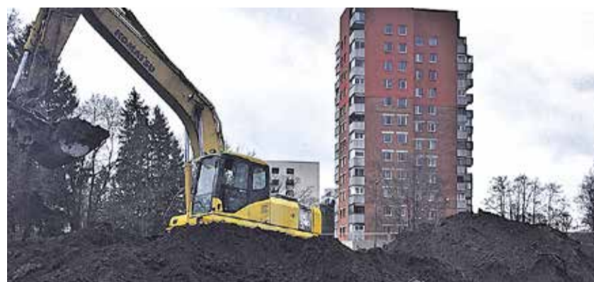
22 марта в Мустамяэ по адресу ул. Кийли, 9 начались работы по строительству Мустамяэской церкви. На стройплощадке работает экскаватор фирмы Ehitus5ECO OÜ.
