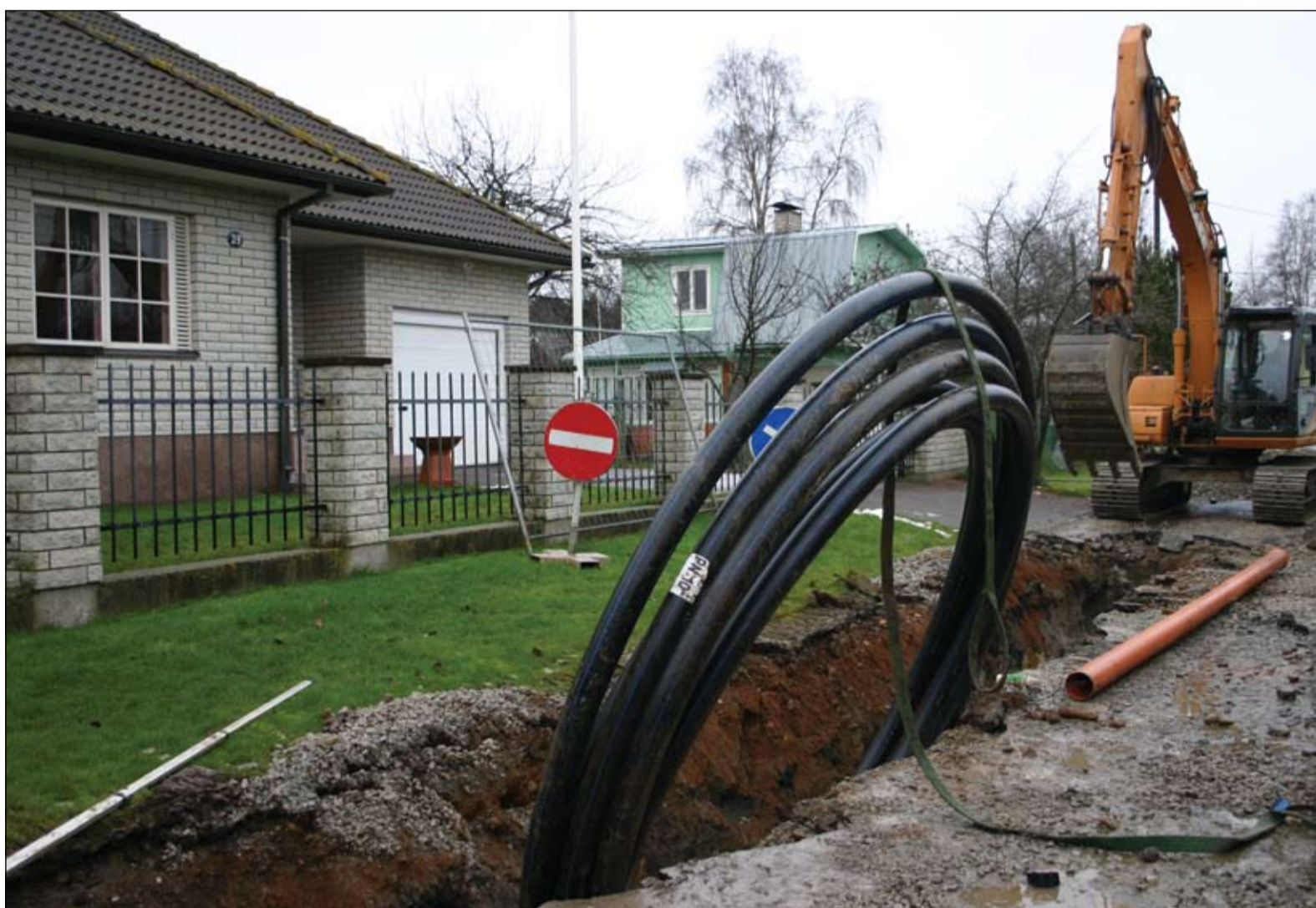
Et ilmad on soojad, käivad Pirital hoogsad kanaliseerimistööd ka detsembrikuus
