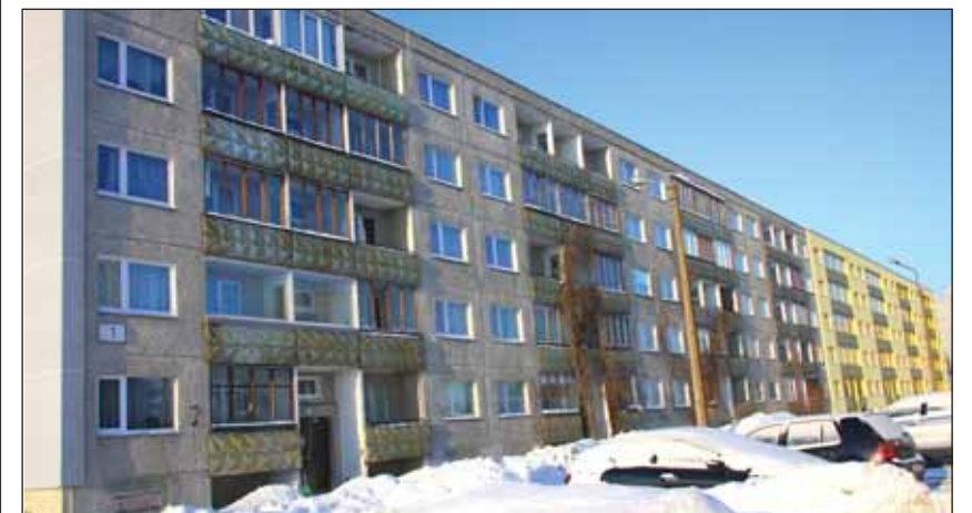
Korteriühistu “Nurmellil” esitas taotluse toetuse saamiseks Eismäe tee 1 elamu fassaadi renoveerimiseks. Linnaosa valitsus kiitis projekti heaks ja esitas taotluse edasi Kommunaalametile, kes teeb lõpliku otsuse toetuse saamiseks. Kõrvalasuv Eismäe tee 3 elamu fassaad on juba renoveeritud.
