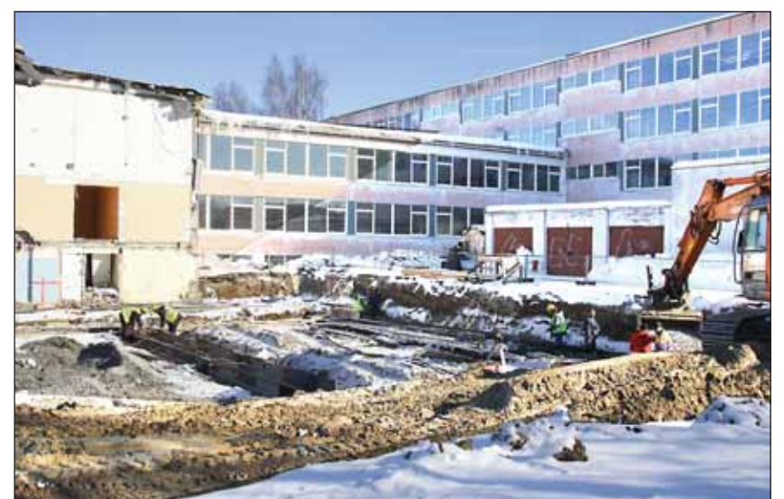
Строительство нового спортивного комплекса.
