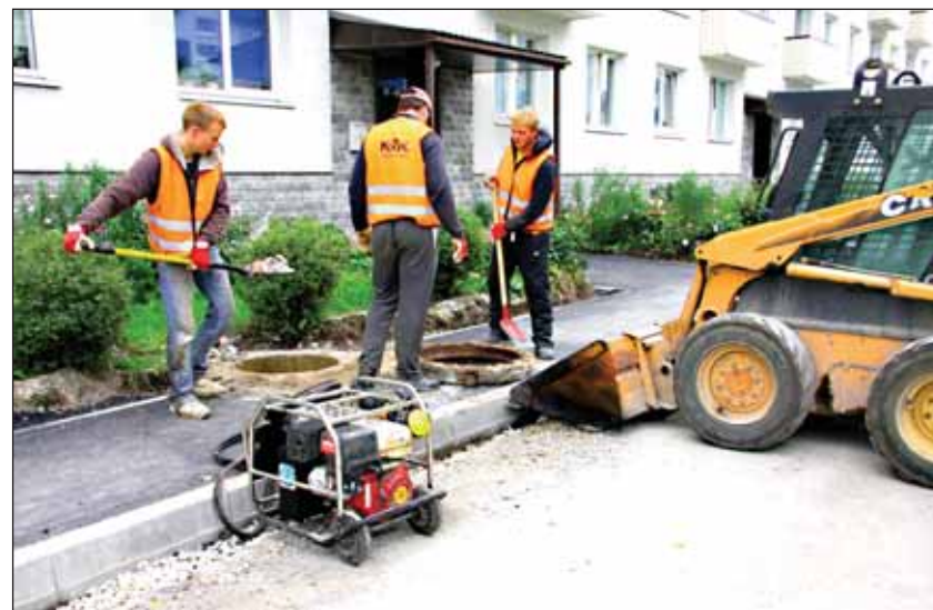
Дорожные работы перед домом 68 на ул. Астангу
