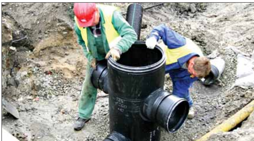
Aasta 2008: kanalisatsioonitrassi ehitamine Piibehele tänaval.
