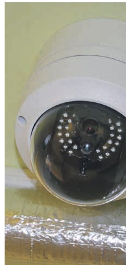
Установку технического охранного оборудования поддерживает пилотный проект «Безопасный дом в Кристийне».
