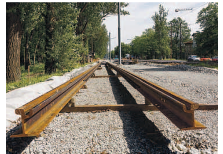
Ремонт трамвайных путей на ул. Копли. Александр Гужов
