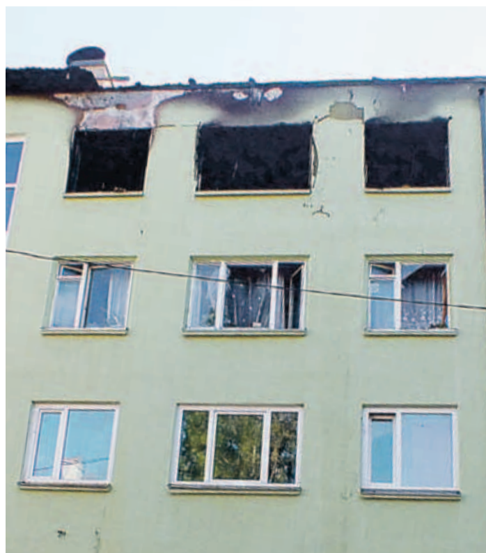
Причиной пожара в жилом доме на ул. Нису стал взрыв газа в квартире на четвертом этаже. © Управа Пыхья-Таллинна
