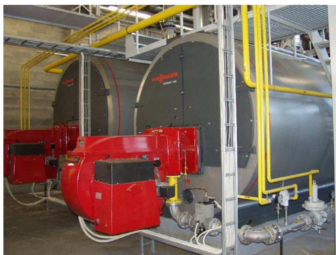
Joonis 7.12. Gaasikütusel töötav lokaalkatlamaja
