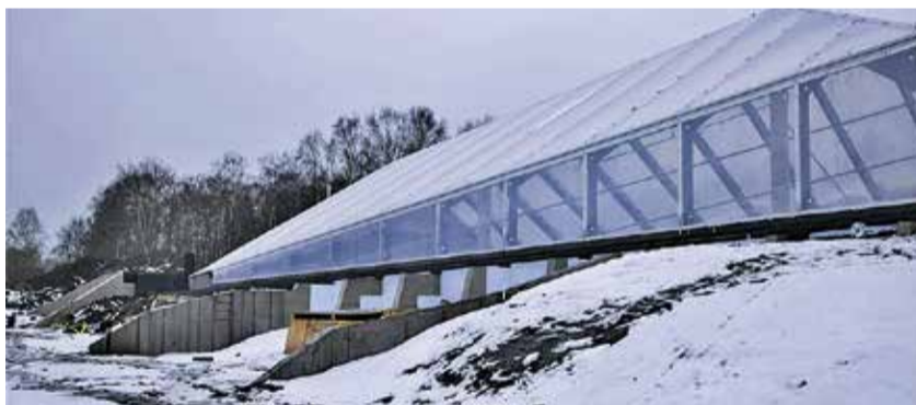
Строящееся здание дождевого леса Юго-Восточной Азии.
